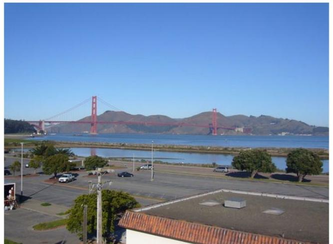
Une la ciudad de San Francisco con el condado de Marin, al norte de la bahía. De rampa a rampa es de 3 km de longitud; fue construido teniendo en cuenta los terremotos y los vientos. La parte suspendida, de 1.280 m., es muy flexible y está sostenida por dos cables principales que tienen un diámetro de 92,6 cm.
